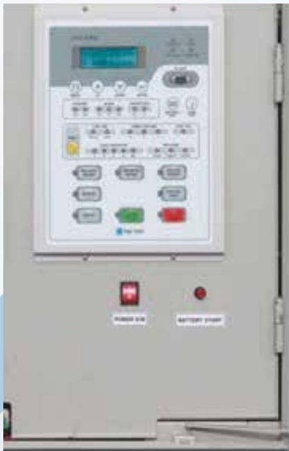
Circuito automático de control del reconector
